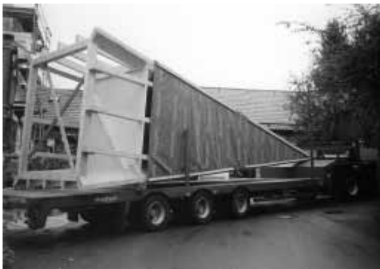
Der Turmspitz wird angeliefert
