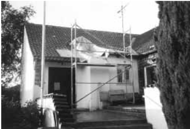
Der „Restturm“ dient als Stütz wand für den neuen Turm
