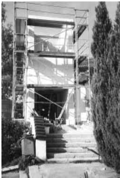
Obergeschoß und Glockenstube sind betoniert
