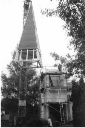
Der Turmspitz am Kran
