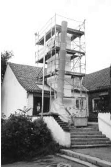
Die Maurescheibe (bisheriger Turm) wird abgetragen
